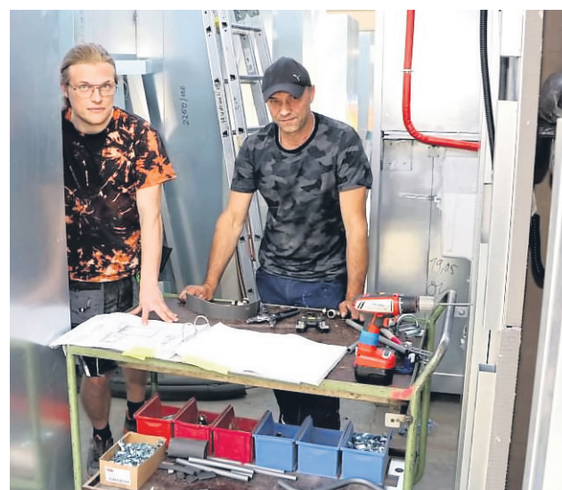
Florian Schock (l.) und Tuzlak Salim installieren die Trinkwasserleitungen an einem Fertigteilbad.
